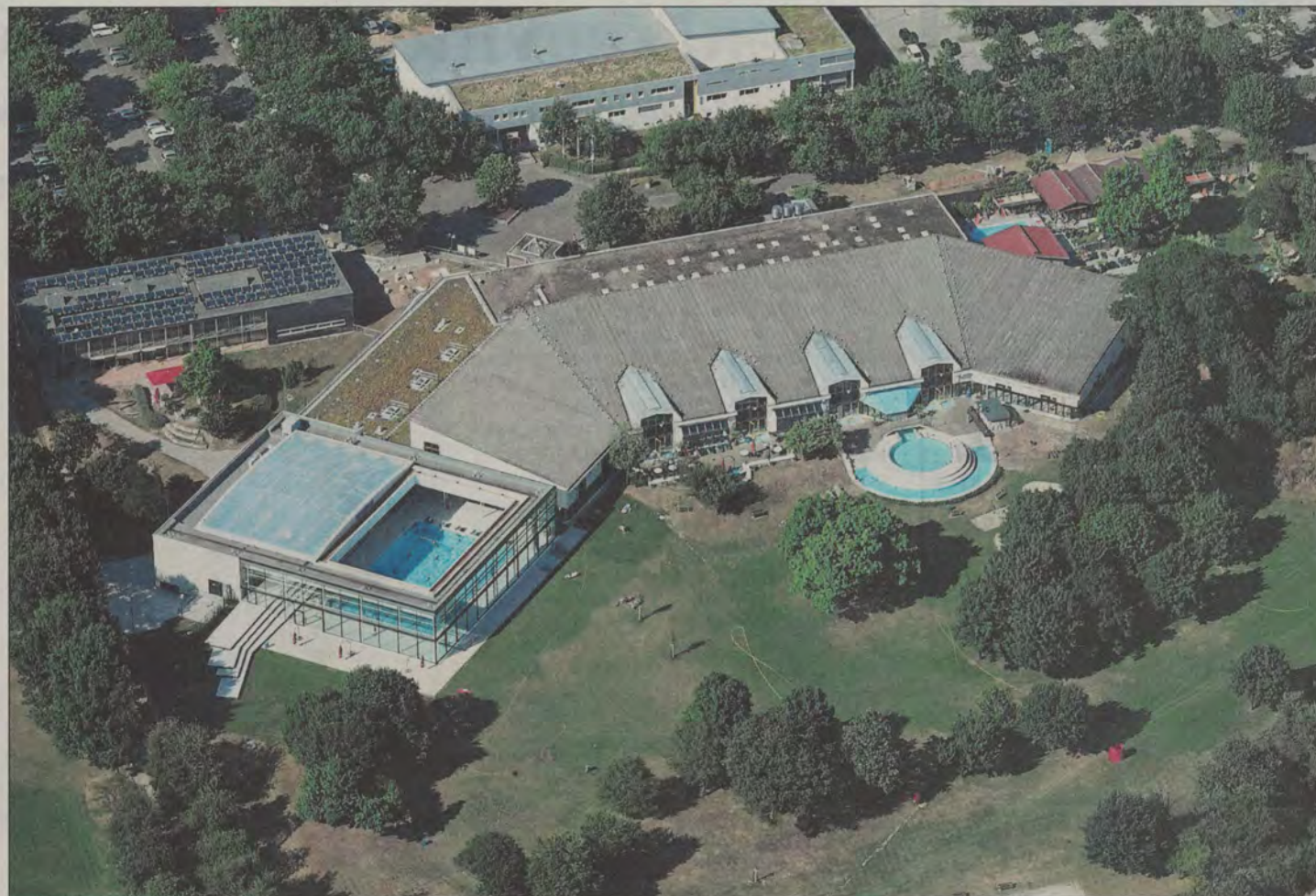
MODERNES BAD: Derzeit wird das Fächerbad noch umgebaut. Ab November sollen die Preise erhöht werden. Für regelmäßige Badesbesucher wird das Schwimmen dann deutlich teurer. Archivfoto: Sandbiller
