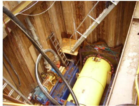
Pressgrube mit 2 Betonrohrabschnitten
