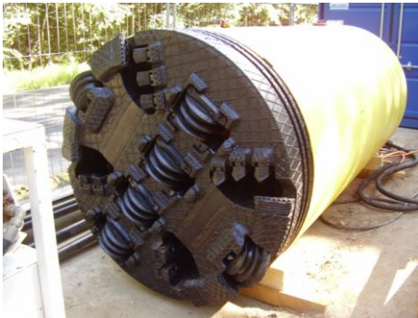
Vortriebsmaschine mit Bohr- und Drehkopf
